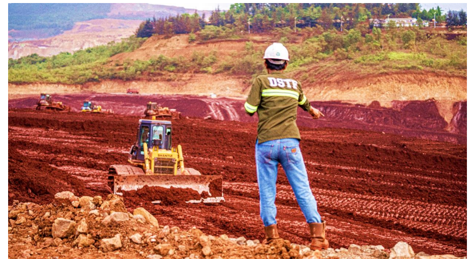
Tailing kering dipadatkan dilahan bekas tambang
