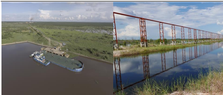
Figure 4. Terminal khusus dan sistem distribusi CPO melalui pipa
